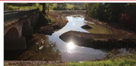
La Frayère après les travaux, où une annexe hydraulique a été créée (partie à l'arrière sur la photo) et est alimentée par l'Armançon (qui passe sous le pont). Photo LBP/Ch. P.
