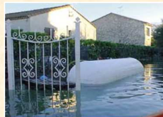
Exemple de cuve soulevée par l'eau
